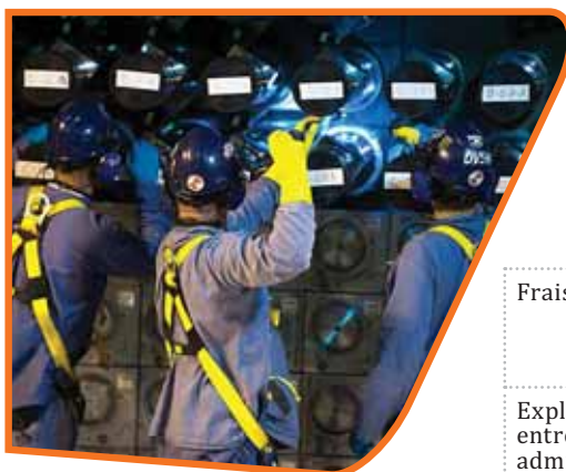
À la centrale de Point Lepreau, des travailleurs installent l'un des 380 canaux de combustible dans la cuve de calandre.
