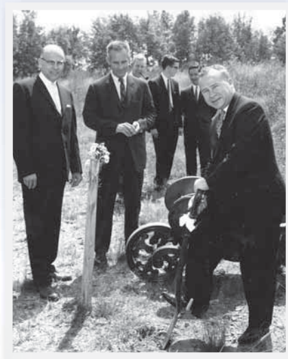
Mai 1964 : L'honorable Louis J. Robichaud, premier ministre du Nouveau-Brunswick de l'époque, procède à la première pelletée de terre au chantier de construction des installations actuelles de RPC situées sur le chemin College Hill.
