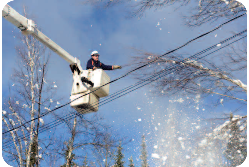
Myles McCurdy, monteur des lignes sous tension, enlève des branches d'arbre d'une ligne de distribution lors d'une tempête hivernale.
