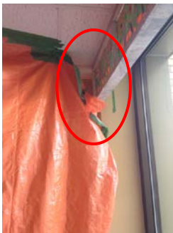
× Secteurs où des travaux de construction sont effectués - cloison inadéquatement scellée au plafond et au plancher
