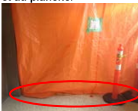
× Secteurs où des travaux de construction sont effectués - cloison inadéquatement scellée au plafond et au plancher
