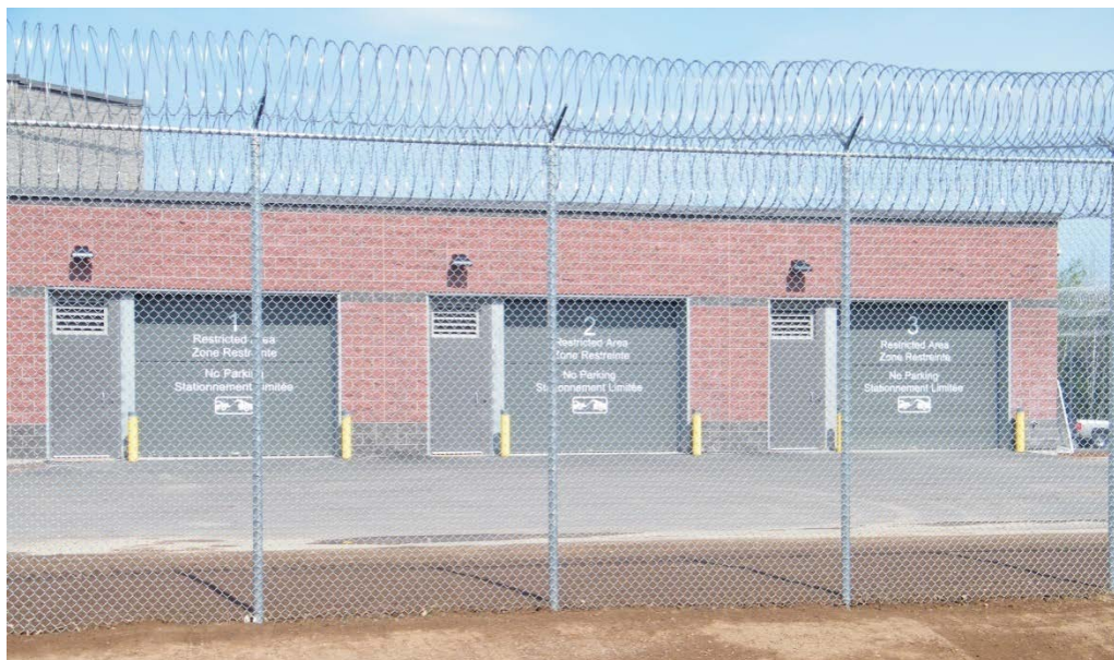
Pièce 3.15 - Extérieur de l'entrée des admissions du Centre correctionnel régional du Sud-Est
