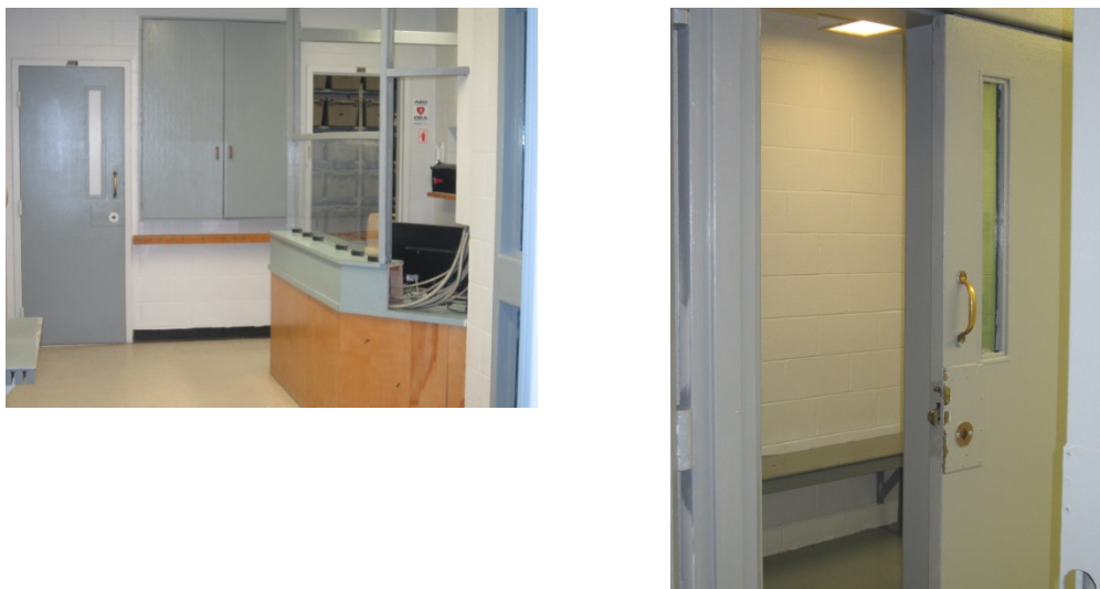
Pièce 3.11 - Aire d'admission et cellule de détention provisoire au CCRSJ
