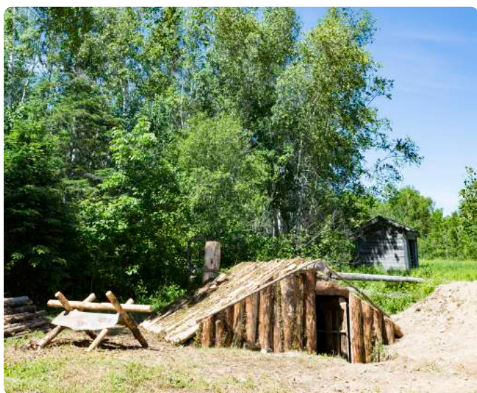
La maison semi-souterraine terminée.
